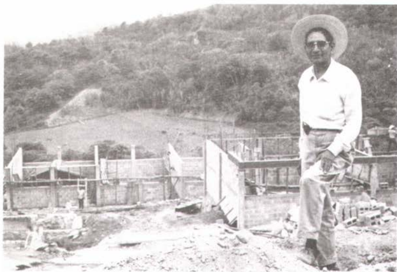
Obras en Guadalupe Tilapa, internado y primaria, región triqui bajos. 1973.
