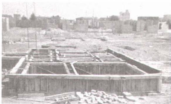
Los pies de casa y su estructura antisísmica.
