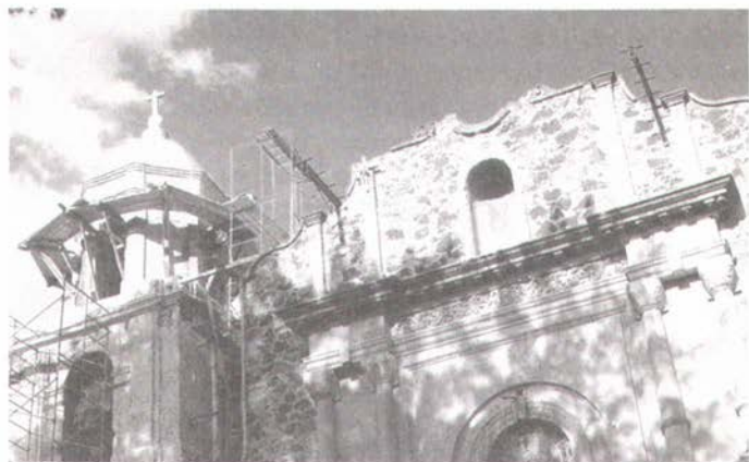
Remodelación de la fachada
