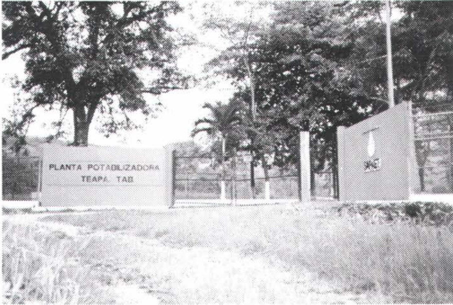
Planta potabilizadora de agua, río arriba
