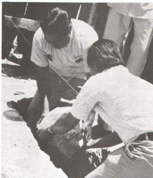
Colocando la primera piedra el 23 de agosto de 1979.
