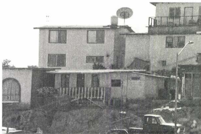
Casas del Barrio de la Aduana
