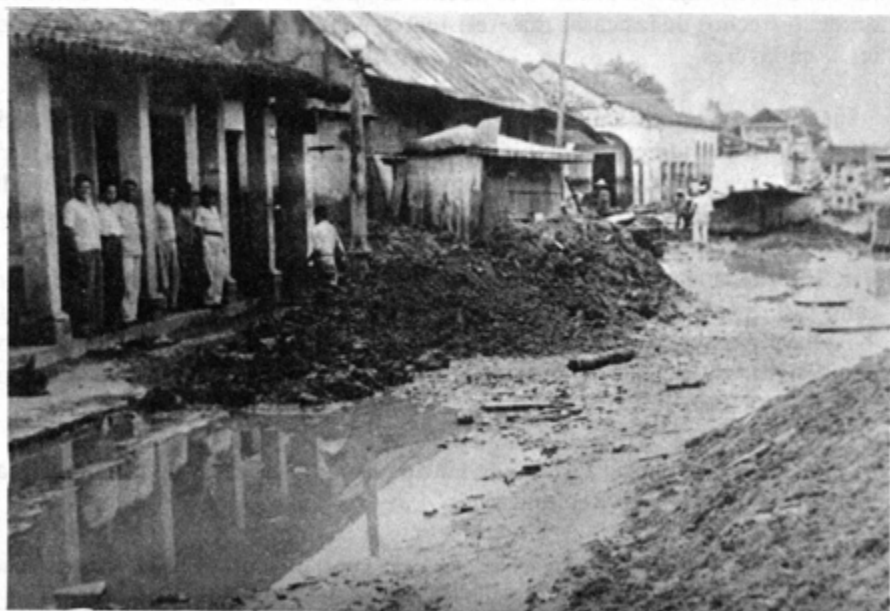
Este era el aspecto de la Avenida Independencia cuando las aguas bajaron de nivel. Una gran cantidad de lodo y escombros se acumulaba por doquier.
