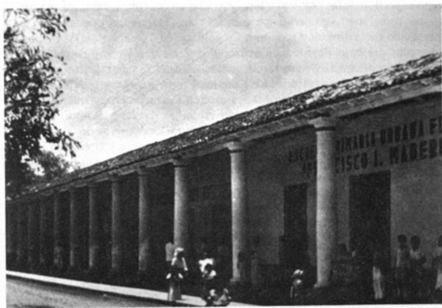
Antigua escuela "Francisco I. Madero" (Av. 5 de Mayo esq. Allende).
