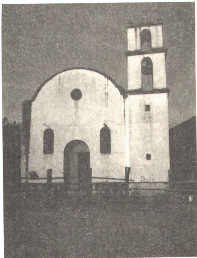
IGLESIA de San José, construida en 1908.
